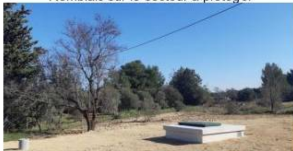
Travaux finis avec étalement des remblais à la pelleuse mécanique
