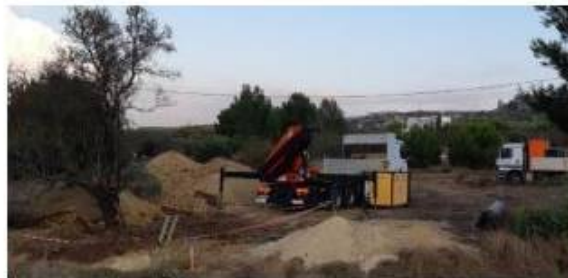
Remblais sur le secteur à protéger
